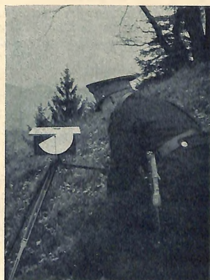
Von Stabsrittmeister Rauba konstruierte Winkelmesser erleichtern das richtige Zeichnen von Böschungen und Kurven.
