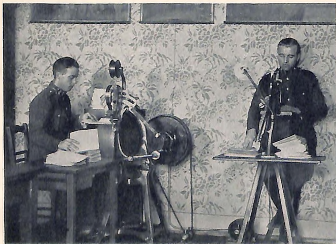
Die beiden Bilder zeigen die Herstellung des täglich erscheinenden Fahndungsblattes bei der Nachrichtenzentrale der königl. ungarischen Gendarmerie in Budapest. — Die Herstellung (Schrift, Bervielfältigung, Zusammenheften, Adressieren) geschieht auf elektrisch betriebenen Maschinen.
