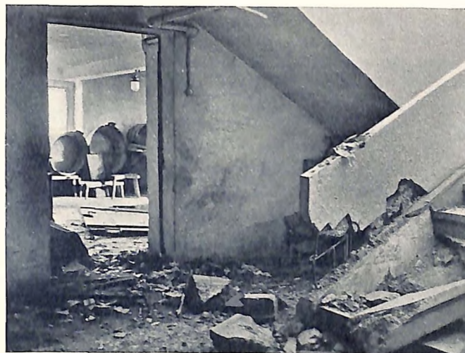
Am 15. Februar l. J. abends wurde auf die Gendarmeriekaserne in Bludenz von unbekanntem Tätern ein Sprengstoffanschlag mit Dynamit verübt, durch den ein Schaden von zirka 1500 Schilling verursacht wurde.
