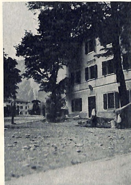
Die Carabinieri-Kaserne in Pontebba nova. Früher das österreichische Grenzpolizeigebäude von Pontafel. Jenseits der Brücke standen nachts die Vorposten der Italiener. Das österreichische Grenzgebäude war von eigenen Patrouillen besetzt.
