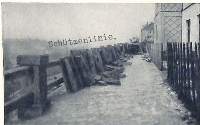
Schutzbund-Schützenstände aus Buchenscheitern auf der „Ennsleite“, Richtung auf die Gendarmeriekaserne.
