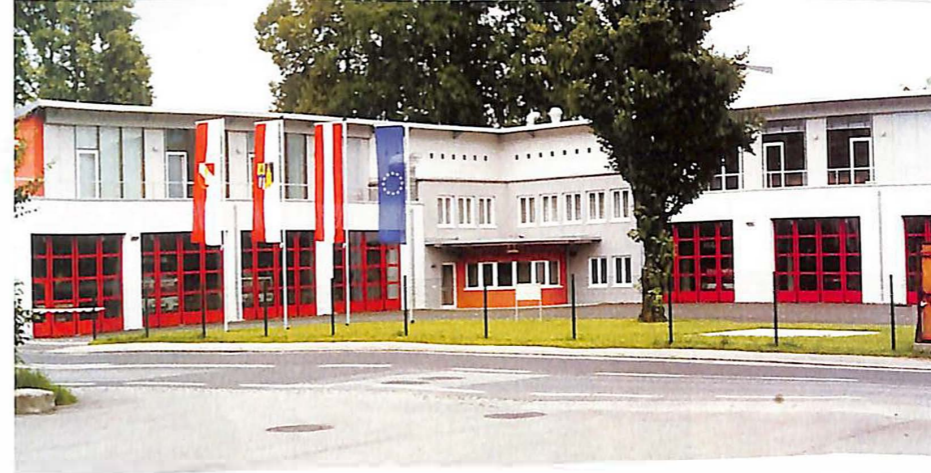
Sicherheitszentrum GP = 1. Stock hinter den Fahnen. Eingang: zur Feuerwehrzentrale. Vordergrund B145 Gmunden-Ebensee.
