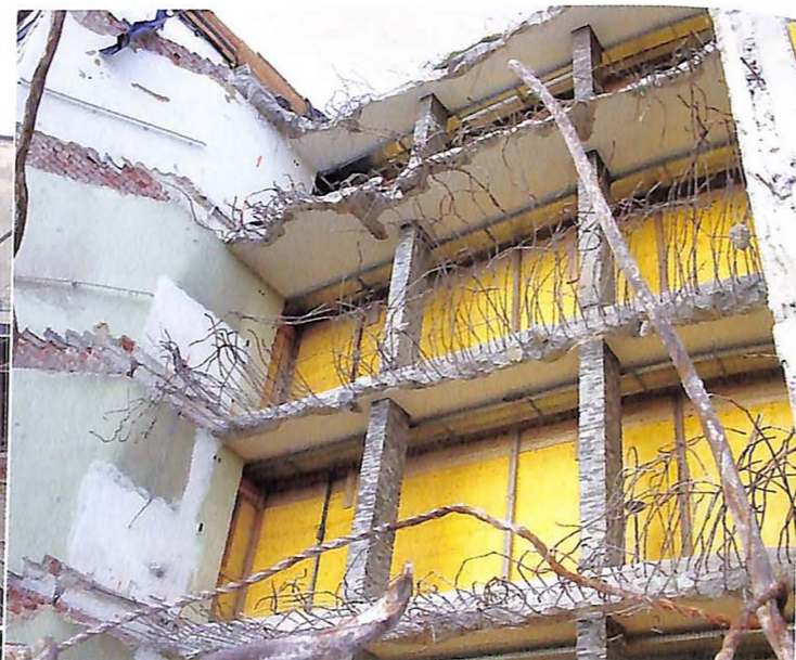
Das Eisenskelett des abgerissenen Stiegenhauses wird sichtbar
