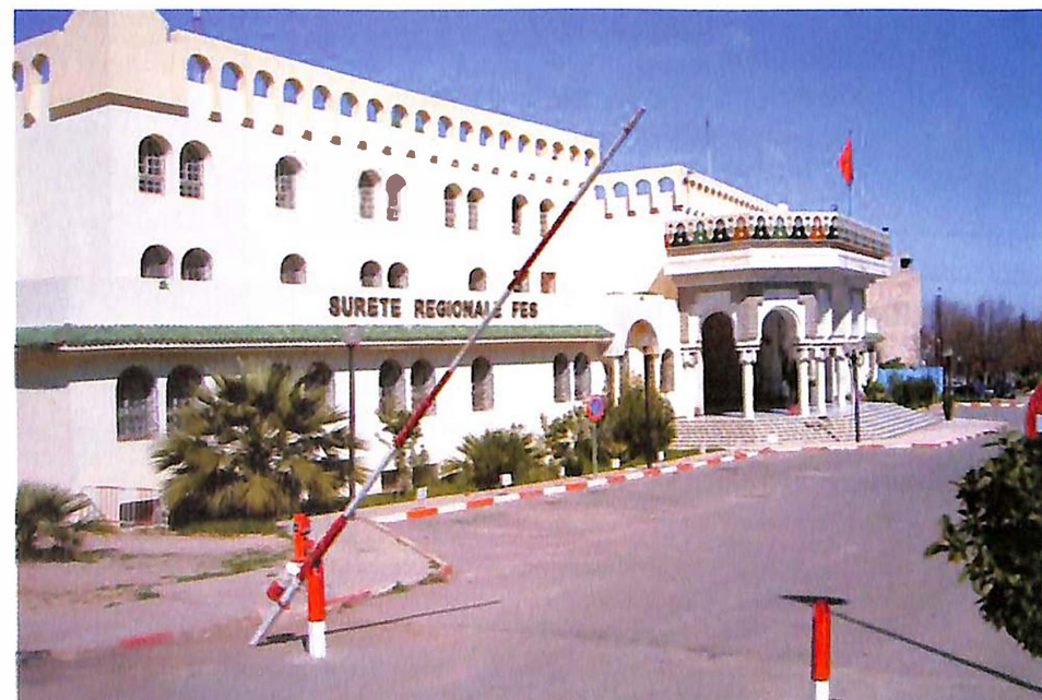
Das Gebäude der „Sûreté Regionale FES“. Ich könnte mir vorstellen, dass hier verschiedene Abteilungen - vergleichbar mit einem Landesgendarmeriekommando - untergebracht sind.
