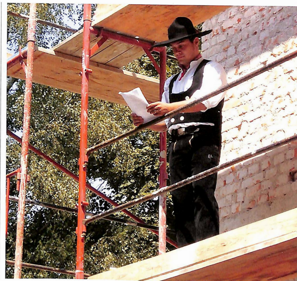
◆ Ein Arbeiter beim sogenannten „Richtspruch“
