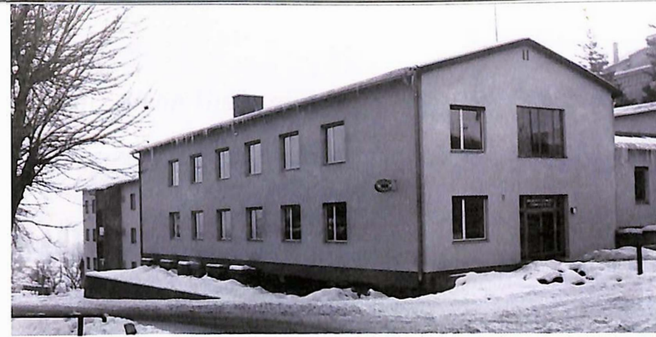
Gendarmerieposten Enns, Unterkunft ab 1970, dzt. stark sanierungsbedürftig.
