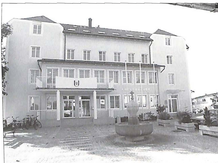
Das generalsanierte Amtsgebäude von Taufkirchen/Pram.
