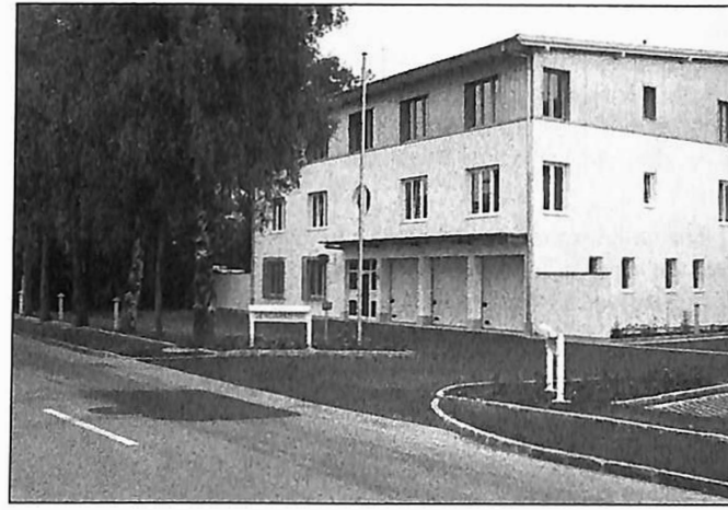
Das neue Gendarmeriegebäude von Braunau.
